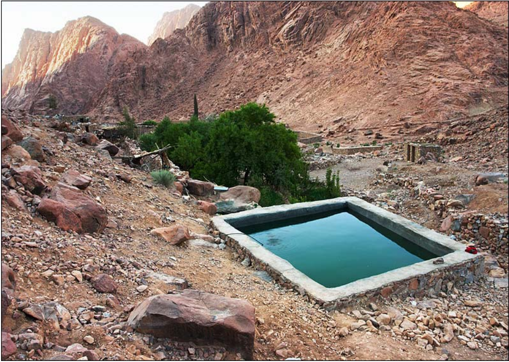
A water reservoir in Wadi El Arbae'in
